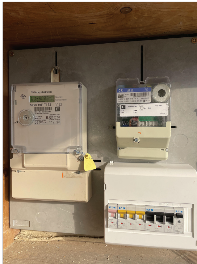
Obr. 26 Elektroměrová deska v původním stavu (vlevo) a rekonstruovaná elektroměrová deska upravená dle přípojovacích podmínek ČEZ pro výrobní, připravená pro výměnu elektroměru a HDO.
